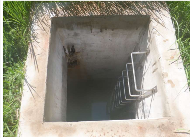
밸브실 진입 사다리 설치 상태양호
