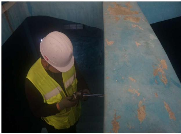
탄산화 깊이 측정
